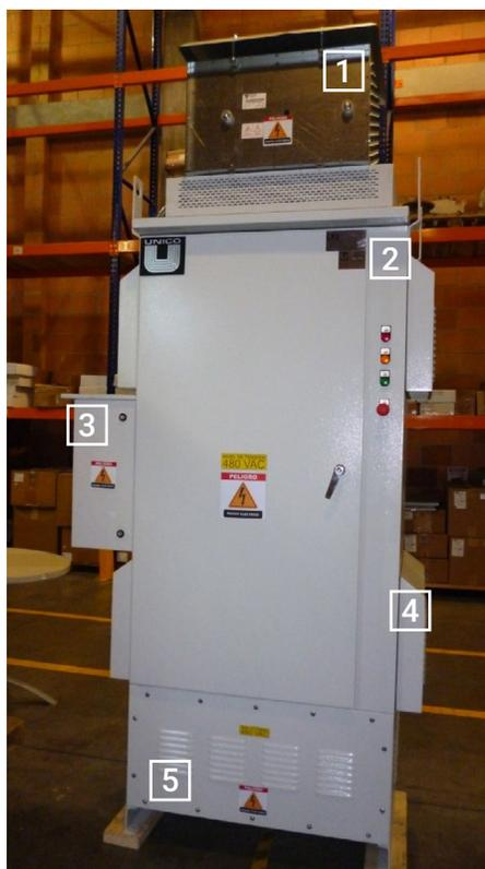
**Imagen 1.** Modelo de un VFA aplicable para un pozo de petróleo que produce por sistema de levantamiento artificial por bombeo (BMC, BCP o BES).
