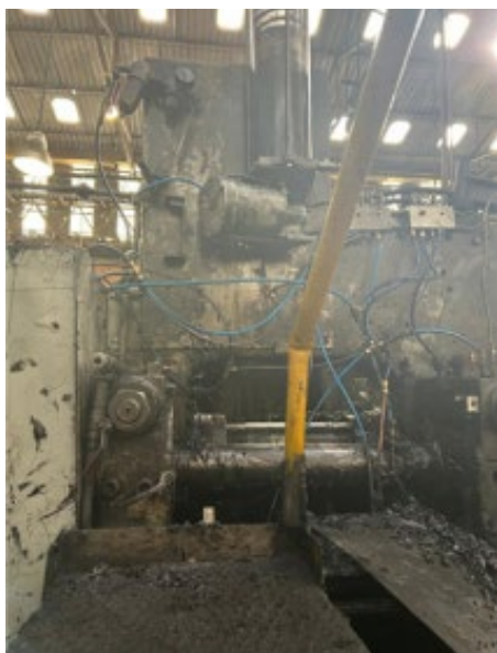
Imagen 2. Residuos de grasa en paredes y piso.
