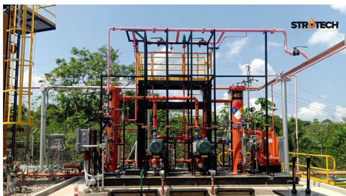
Figura 2. Sistema de Acondicionamiento para Microturbina.
