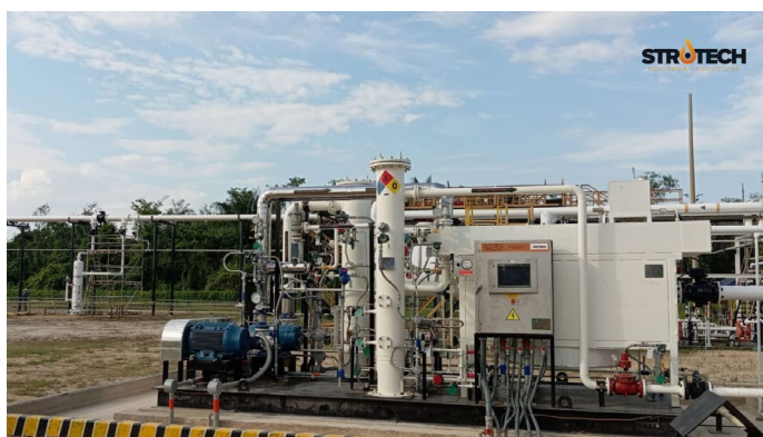
Figura 1. Sistema de Acondicionamiento para motor.
