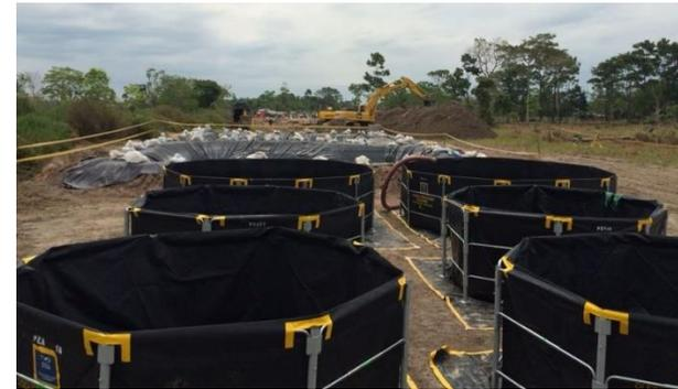
**Producto:** Tanques y diques de armado rápido
