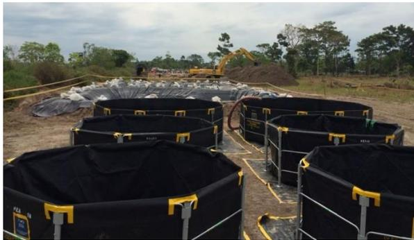
**Producto:** Tanques y diques de armado rápido
