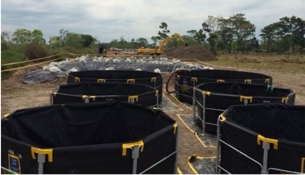
**Producto:** Tanques y diques de armado rápido
