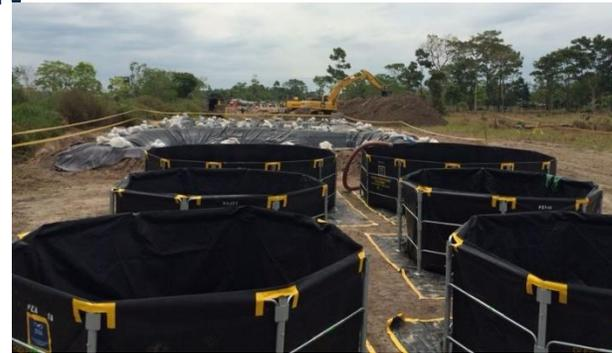
**Producto:** Tanques y diques de armado rápido
