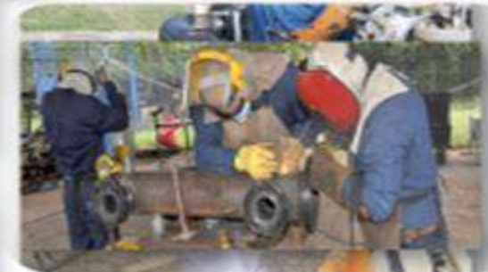
Montajes Industriales y Soldadura
