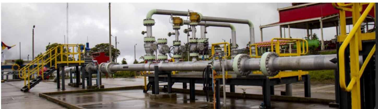
Fuente: Cenit – Estación Miraflores.
