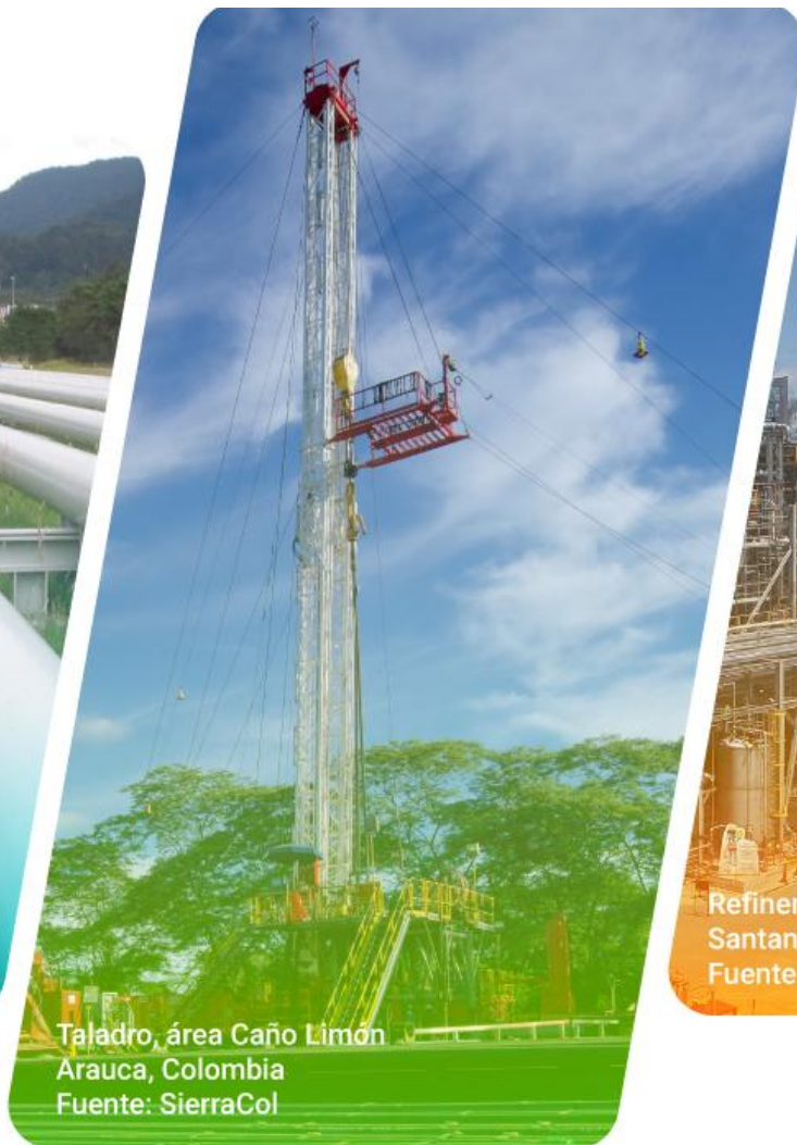
Oleoductos, área Caño Limón Arauca, Colombia Fuente: Ecopetrol
