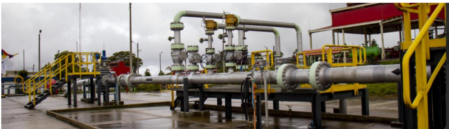
Fuente: Cenit – Estación Miraflores.
