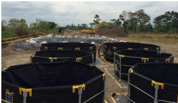
**Producto:** Tanques y diques de armado rápido
