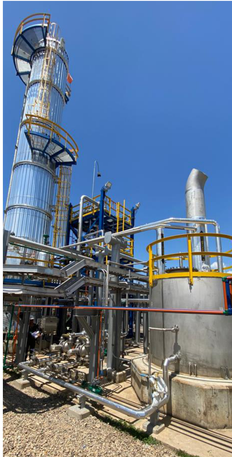
Actualización de tanque de tratamiento de aguas residuales Fotografía de RHEMA Internacional S.A.S.
