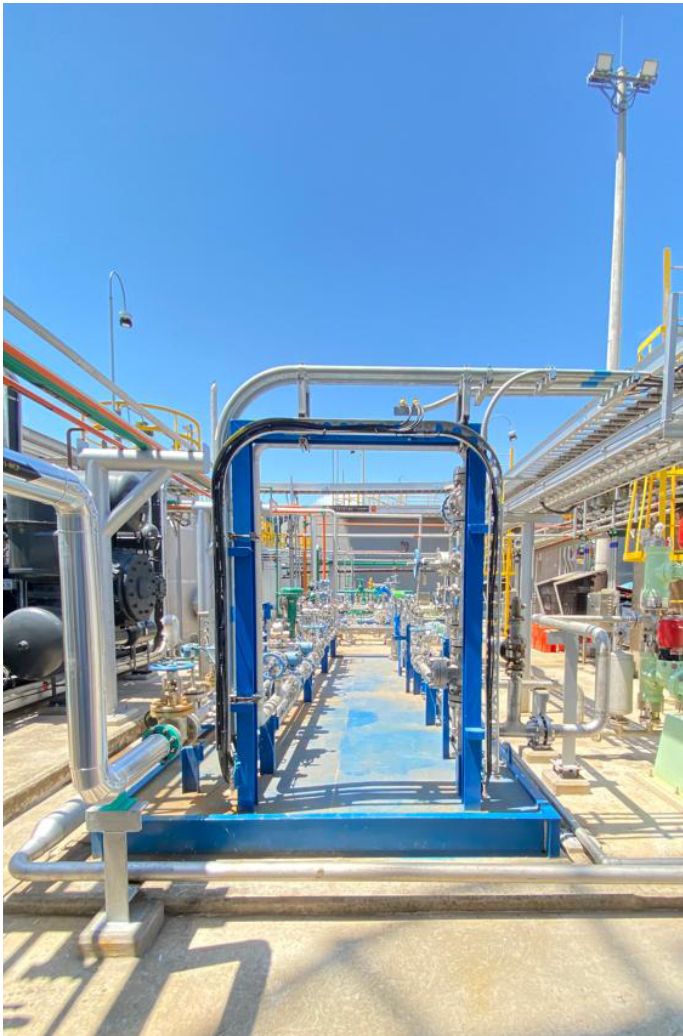
Actualización de tanque de tratamiento de aguas residuales Fotografía de RHEMA Internacional S.A.S.
