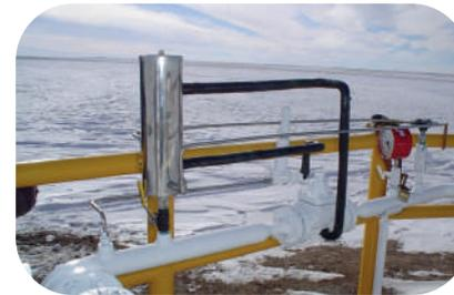
Sistema de pre-enfriamiento, y enfriamiento para recuperación de condensados del gas natural.
