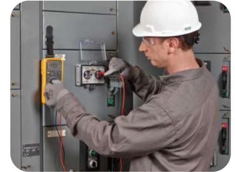
Dispositivo indicador y punto de prueba de medición de tensión.
