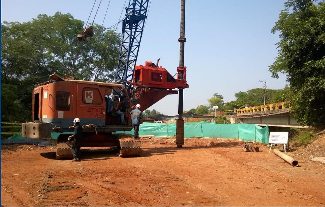
Construcción de pilotes preexcavados desde plataforma en tierra para los puentes ubicados en zona sur vía Ruta del Sol sector 2.
