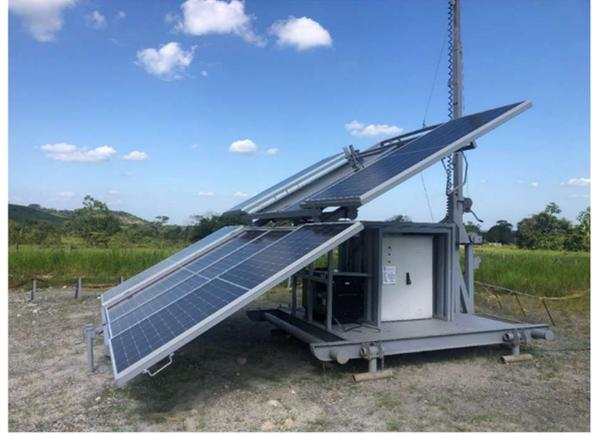
Unidad de generación para garantizar el abastecimiento energético en operaciones de Well Testing y Subsuelo.
