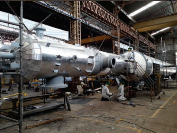
Obra: Tuberías en planta de estabilización de condensados y Recubrimientos Flexibles, CPF Cupiagua , Aguazul - Casanare . Instalación: Material Aislante pyrogel y proteccion mecánica lamina lisa de aluminio para tuberías, valvulas en recubrimientos flexible
