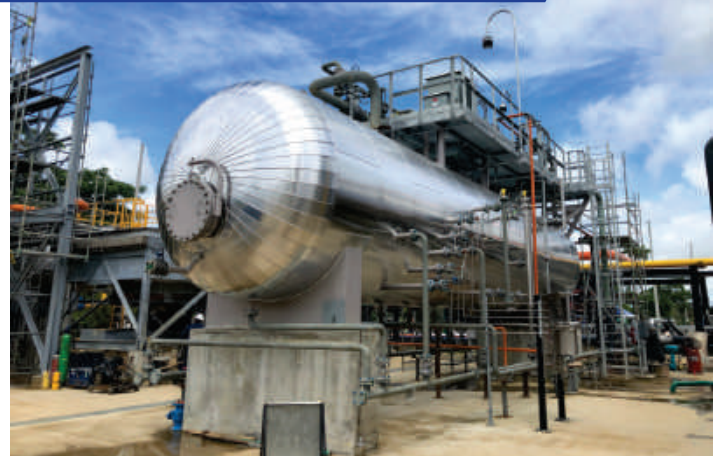
Obra: Tanques Fwko e Intercambiadores Campo Acordeonero, San Martín - Cesar Instalación: Material Aislante Insul Quick y protección Mecánica Lamina lisa de Aluminio
