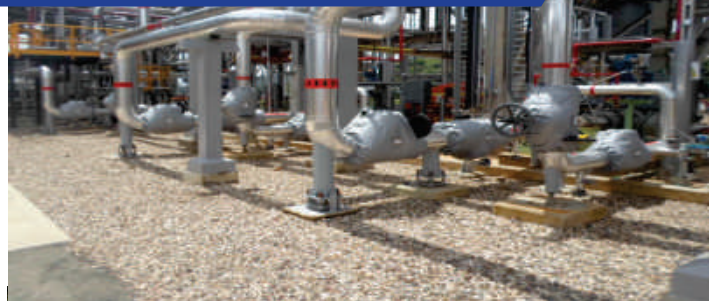
Obra: Tuberías en planta de estabilización de condensados y Recubrimientos Flexibles, CPF Cupiagua , Aguazul - Casanare . Instalación: Material Aislante pyrogel y proteccion mecánica lamina lisa de aluminio para tuberías, valvulas en recubrimientos flexible
