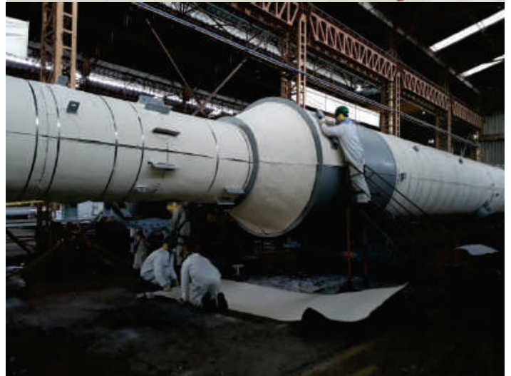
Obra: Tuberías en planta de estabilización de condensados y Recubrimientos Flexibles, CPF Cupiagua , Aguazul - Casanare . Instalación: Material Aislante pyrogel y proteccion mecánica lamina lisa de aluminio para tuberías, valvulas en recubrimientos flexible
