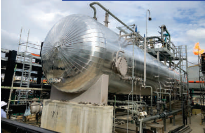
Obra: Tanques Fwko e Intercambiadores Campo Acordeonero, San Martín - Cesar Instalación: Material Aislante Insul Quick y protección Mecánica Lamina lisa de Aluminio
