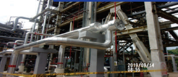
Obra: Tuberías en planta de estabilización de condensados y Recubrimientos Flexibles, CPF Cupiagua , Aguazul - Casanare . Instalación: Material Aislante pyrogel y proteccion mecánica lamina lisa de aluminio para tuberías, valvulas en recubrimientos flexible
