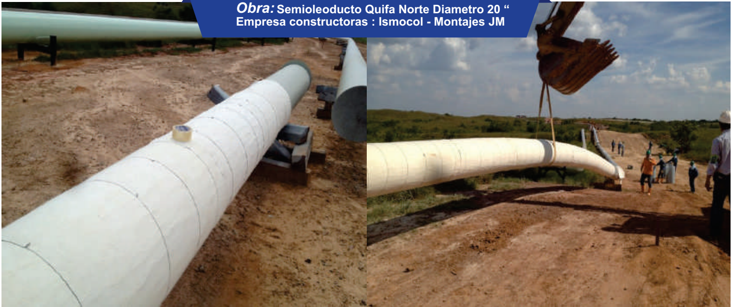
Obra: Semioleoducto Quifa Norte Diametro 20 " Empresa constructoras : Ismocol - Montajes JM
