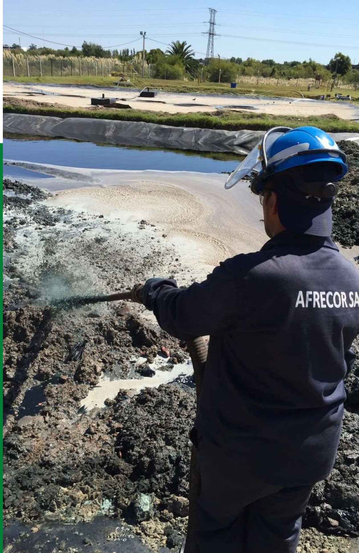
LIMPIEZA DE LAGUNA
