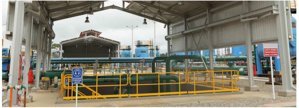
Shelters para Bombas, Equipos Eléctricos y Sistemas de inyección Occidental Estación Cira Infantas LCI3A.
