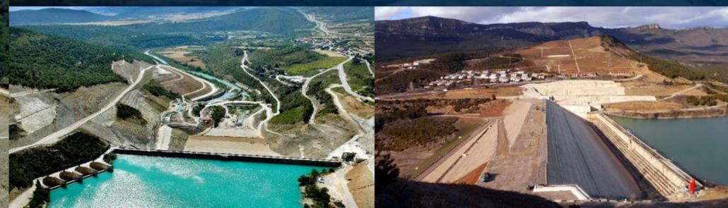
Supervisión de las obras de recremento de la presa de Yesa hasta una **altura de 108 m**, mediante una presa de gravas con pantalla de hormigón apoyada sobre la presa existente. De este modo, se duplica la superficie inundada y se triplica la **capacidad del embalse hasta 1.525 Hm<sup>3</sup>**, con el fin de **aumentar la capacidad de regadío** de la zona.
