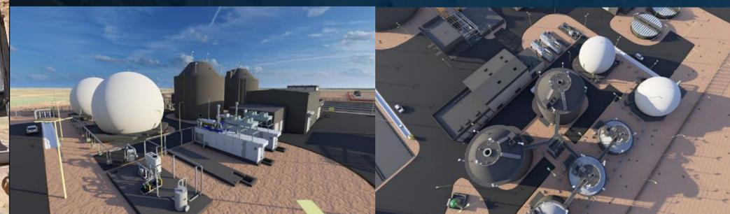
Elaboración del diseño de tres nuevas plantas depuradoras para una población de hasta **1.667.000 habitantes** equivalentes y una capacidad máxima de hasta **300.000 m<sup>3</sup>/día**, bajo la modalidad **DBOT** (diseño, construcción, explotación y transferencia). Los diseños se han desarrollado mediante **tecnología BIM**.
